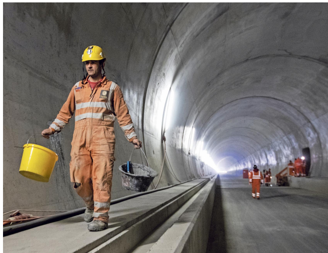
Bau des Bözbergtunnels: Eine unterirdische Verkehrslösung geht ins Geld.
