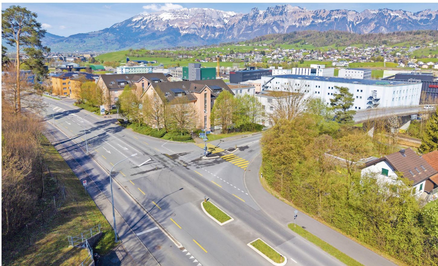
Bisher gibt es weder einen Kreisel noch eine Ampel: Die Kreuzung Vorarlbergerstrasse/Rietstrasse in Schaanwald wird aufgrund des baulichen Zustands und des erwarteten Mehrverkehrs umgestaltet. Bild: Daniel Schwendener
