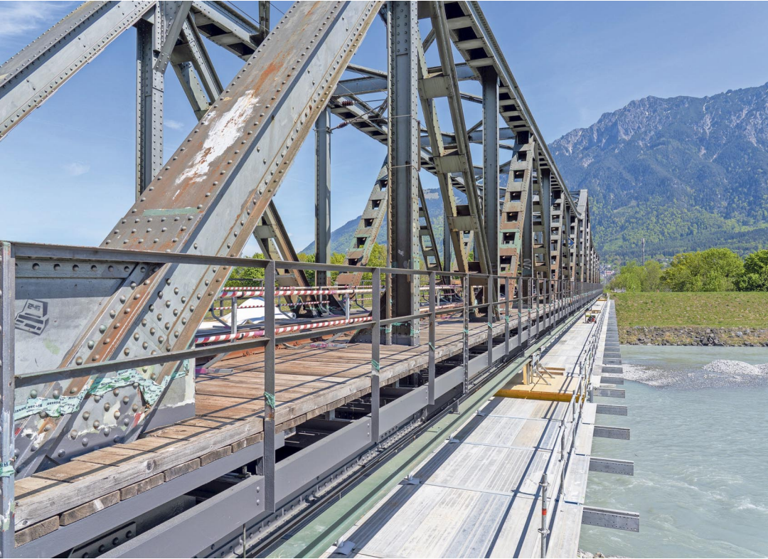
Auch die Rheinbrücke wird saniert und mit einem Korrosionsschutz versehen. Bild: ÖBB/Sailerbrothers
